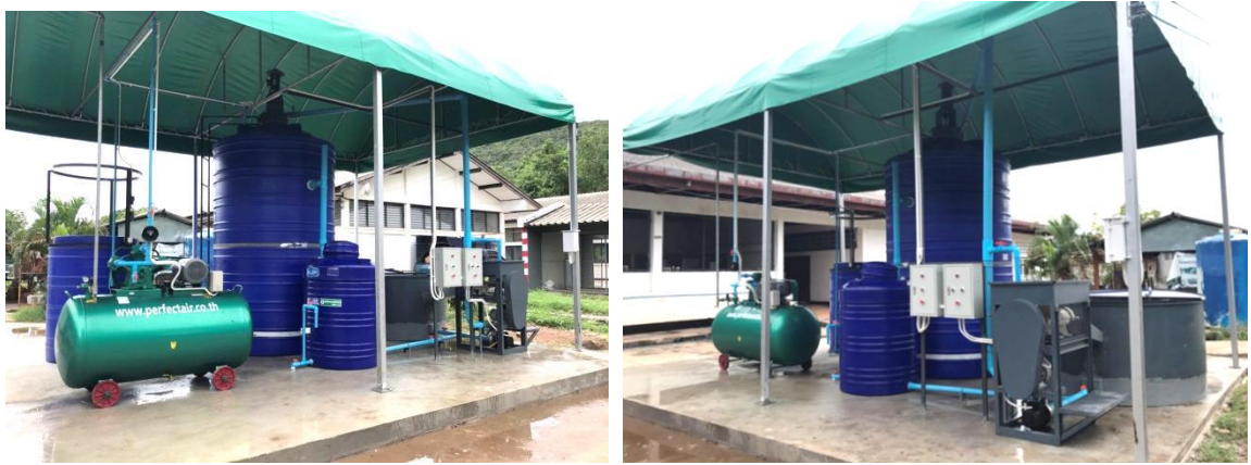
ภาพชุดถังหมักขยะอินทรีย์เพื่อผลิตก๊าซชีวภาพที่ติดตั้งให้แก่ละชุมชน
